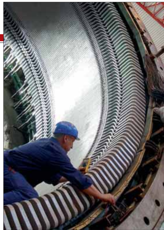
Монтажа ротора, тешког 150 тона
