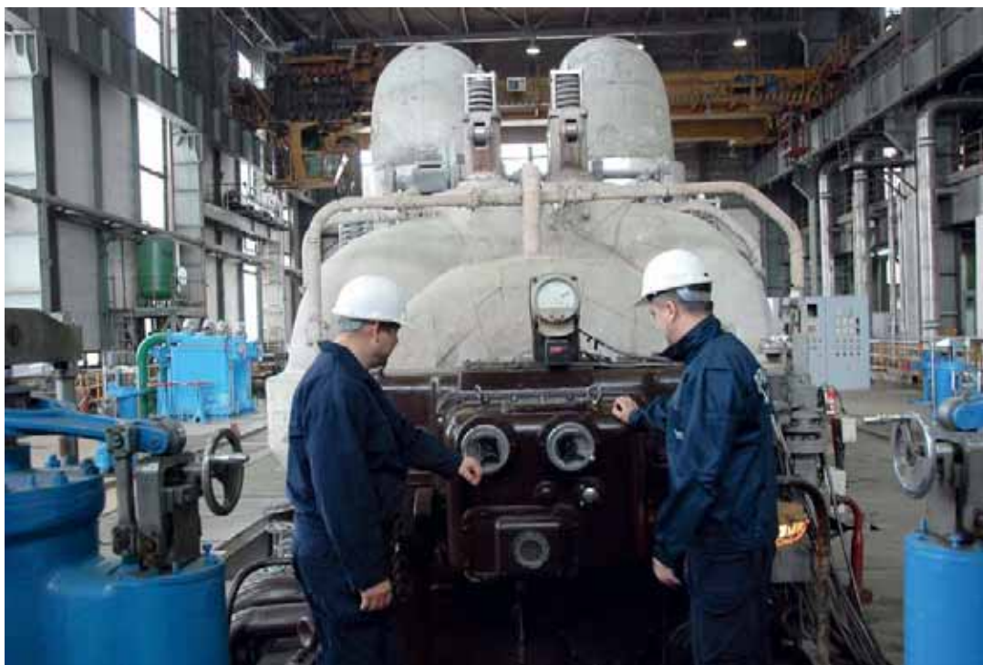
У ТЕ „Костолац А-2“ капитални ремонт турбине најважнији посао
