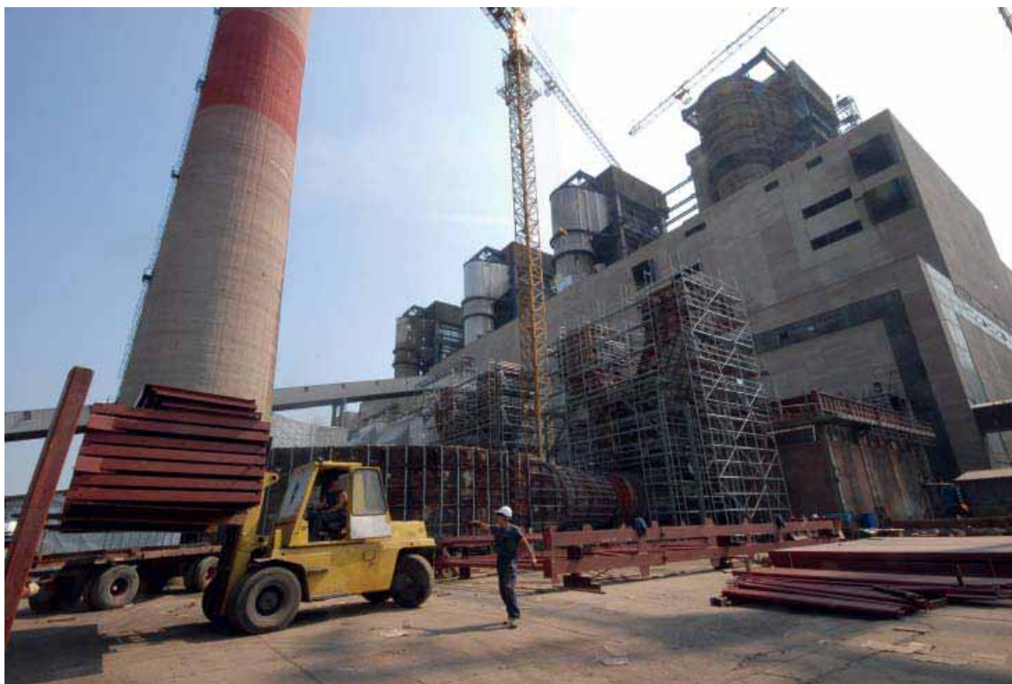
У реконструкцију електрофилтера на блоку А 6 уложено 7,6 милиона евра
