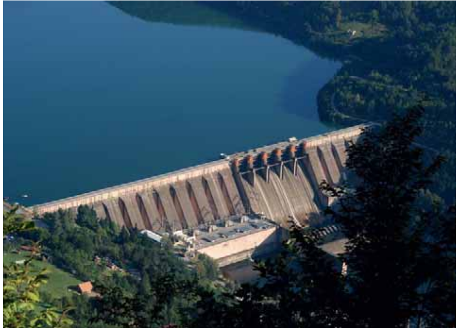
У ХЕ „Бајина Башта“ ремонт помоћних, па главних објеката
