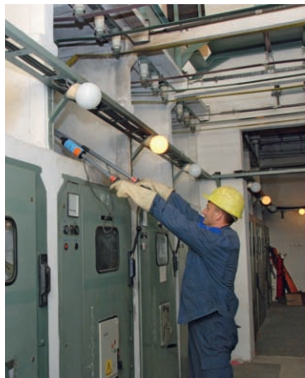
■ Једна од трафо-станица 35/10 kV
