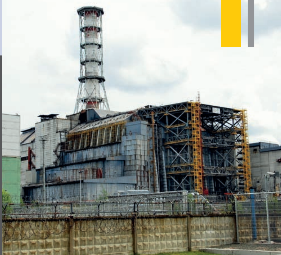
На уништеном постројењу НЕ „Чернобил“ поставља се нови саркофаг
