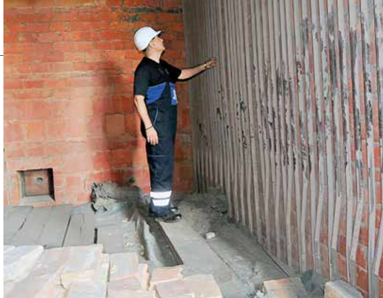
■ Зоран Вујаклија у унутрашњости котла
