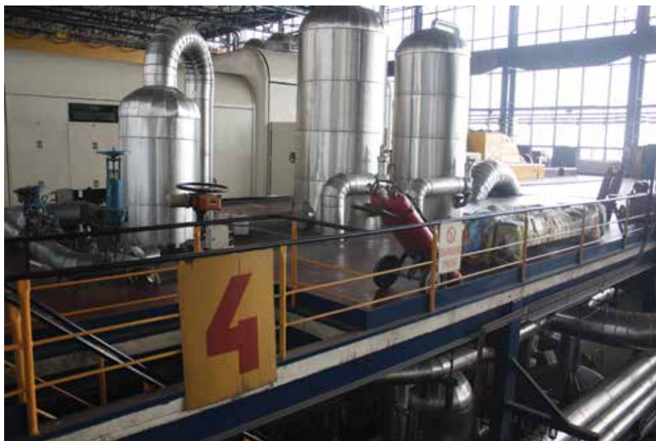
■ Блок А4 се припрема за капитални ремонт следеће године
