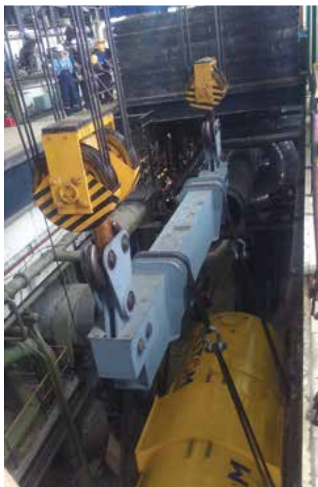
■ Подизање новог статора
