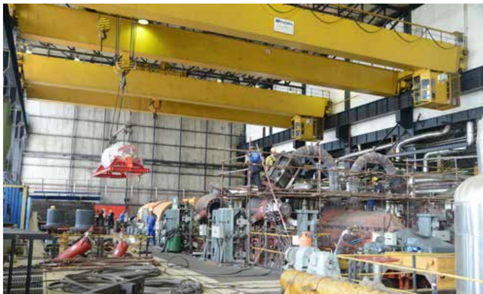
Ремонтни радови на блоку Б2
