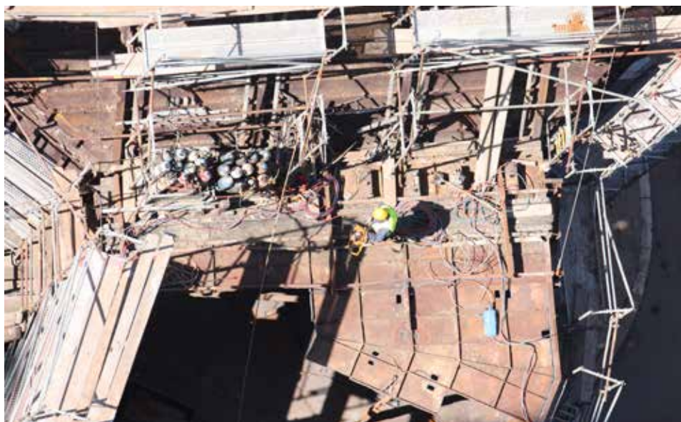
Радови на електрофилтеру блока ТЕНТ Б1 2012. године
