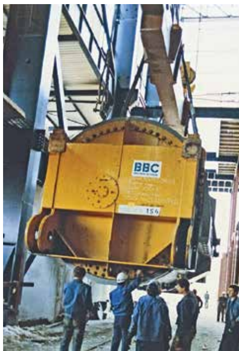
■ Подизање статора приликом изградње блока Б2 1984. године
