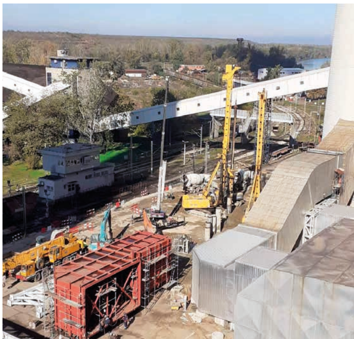
■ Бушење и бетонирање шипова за апсорбер блокова 3 и 4
