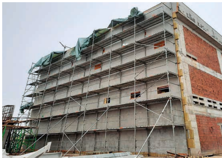
■ Електро-командна зграда кречњака и гипса - израда фасаде
