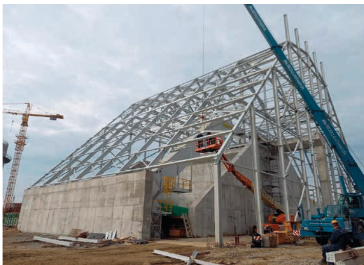
■ Зграда за складиштења кречњака - монтажа челичне конструкције
