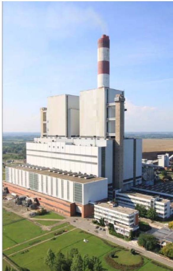
Slika 3 Termoelektrana „Nikola Tesla B“
