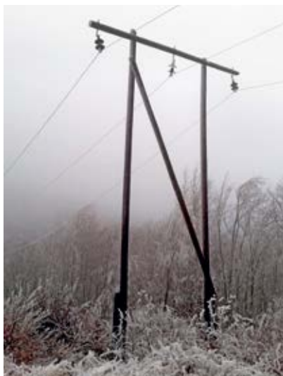
■ Далековод пре и после реконструкције
