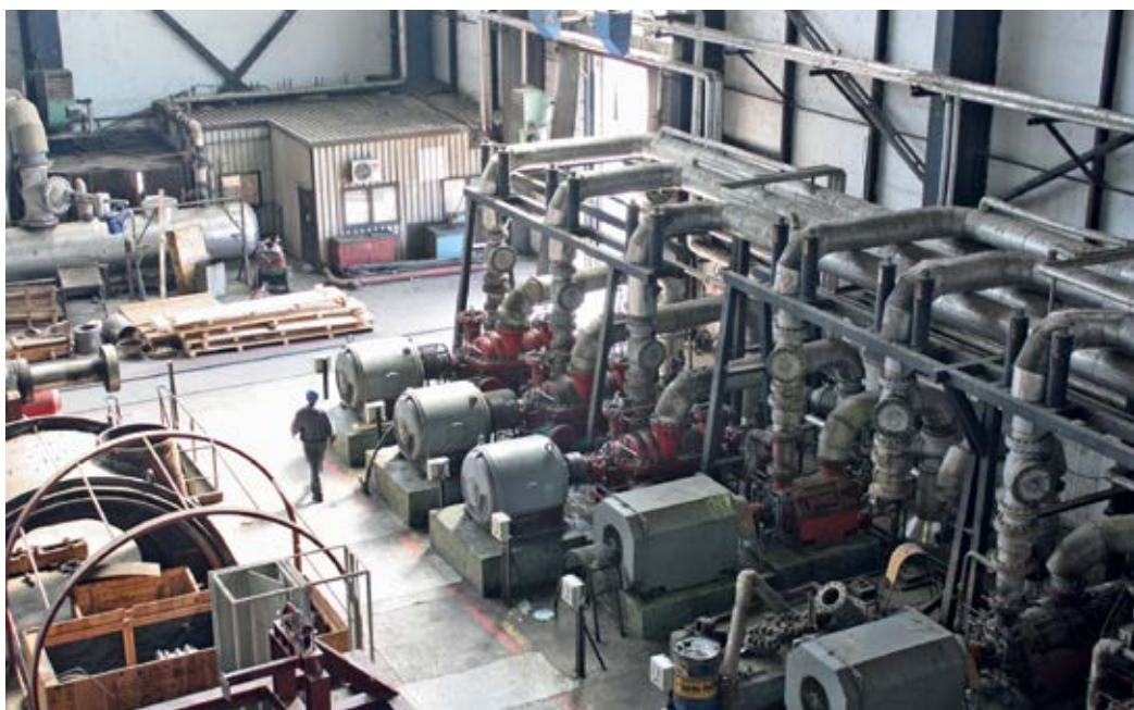
■ Систем пумпи за грејање Обреновца на VII блоку ТЕНТ А
