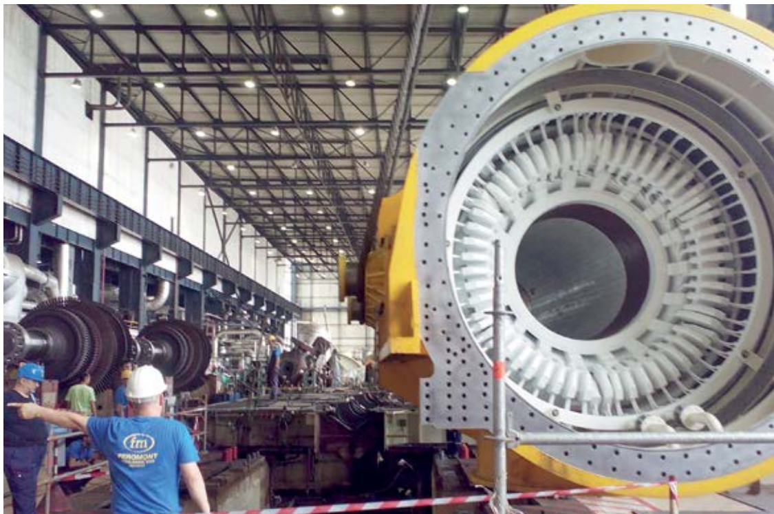
■ Монтирање новог статора
