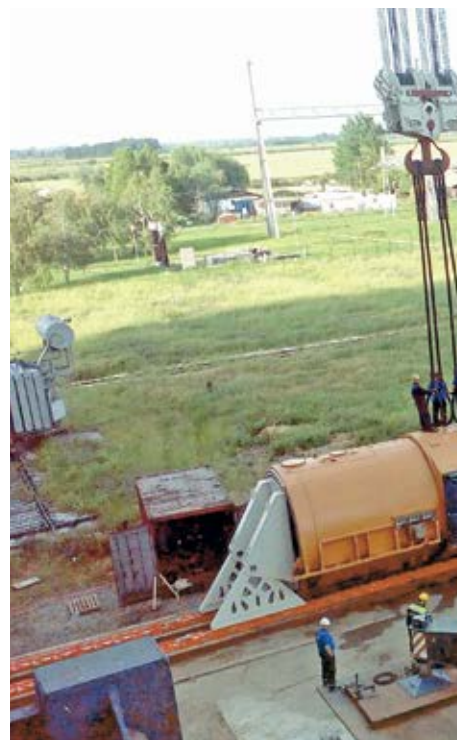
■ Спуштање старог статора генератора на специјалне
