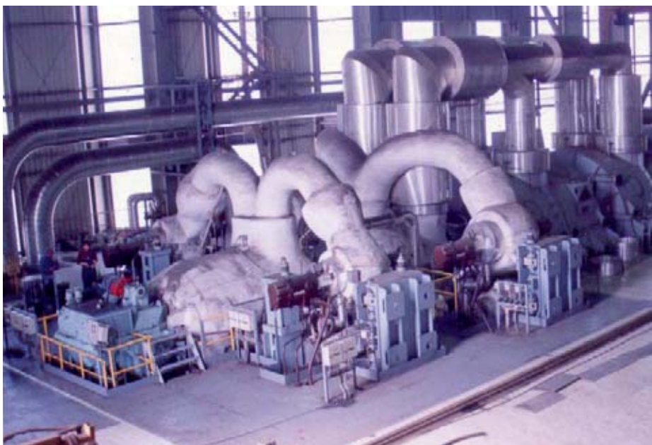
У ремонту блока А 2 биће модернизован и систем за управљање
