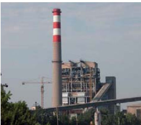
Реконструкција и уређаја за догоревање
