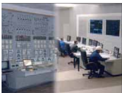
Контролне собе у ТЕ "Рјазањ" пре и после увођења система Квинт
