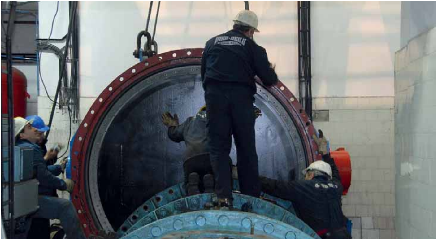
Монтажа предтурбинског затварача
