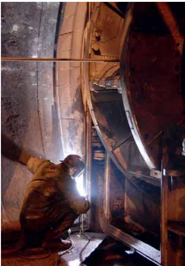
Блок А 4: урађена санација опреме оштећене абразијом
