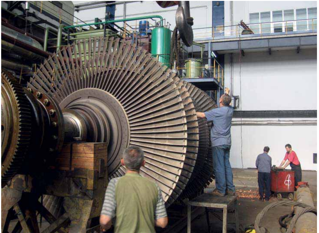
Радови на поправци лопатица блока А-2
