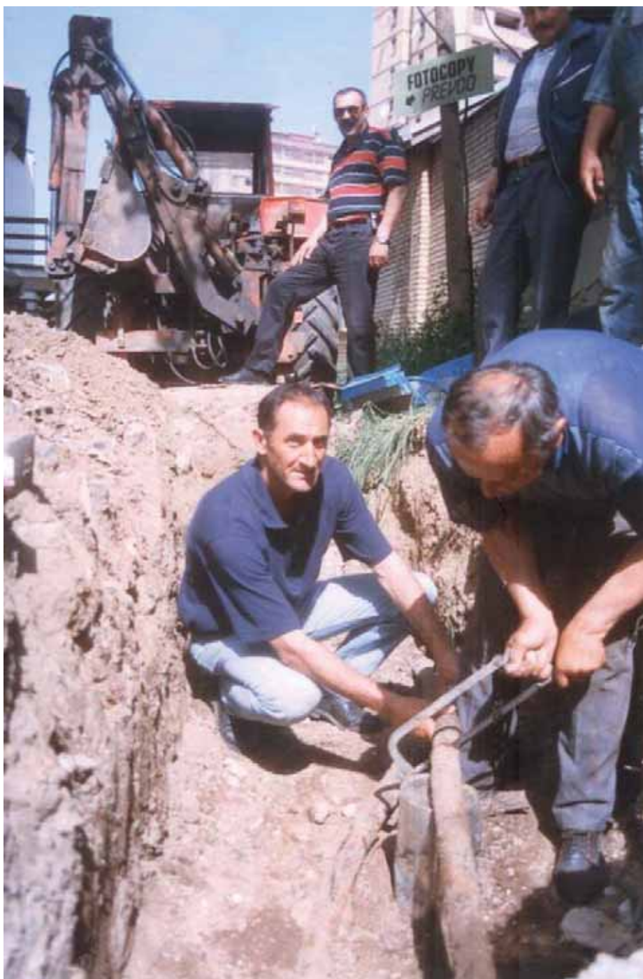
Санација 10 kV кабла у центру Приштине
