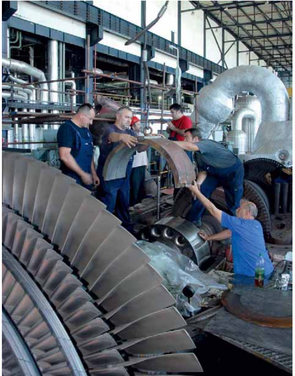
У току ремонт турбине, а успут биће вађен и ротор
