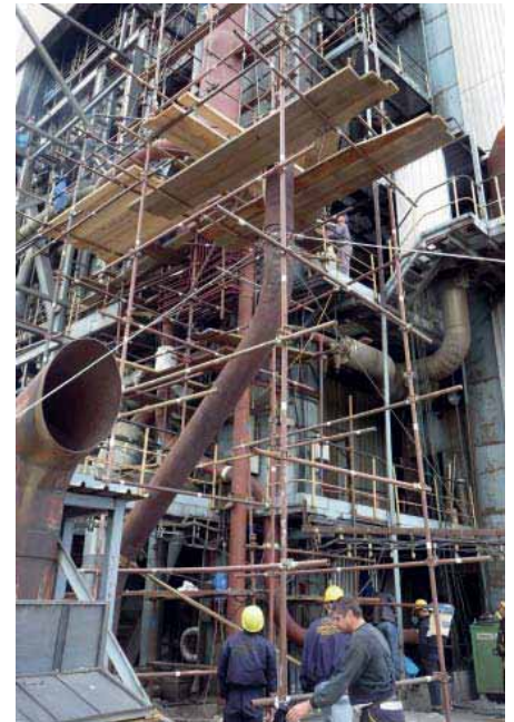
Обимни ремонтни послови
