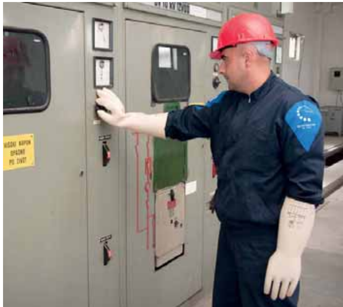
Из трафо-станице „Ниш-8“ у изградњи
