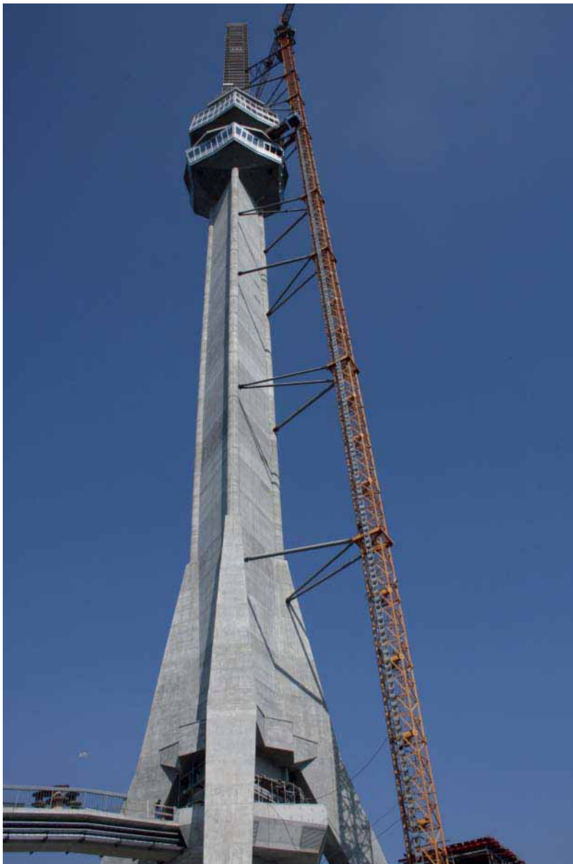
Изградња Авалског торња у завршној фази
