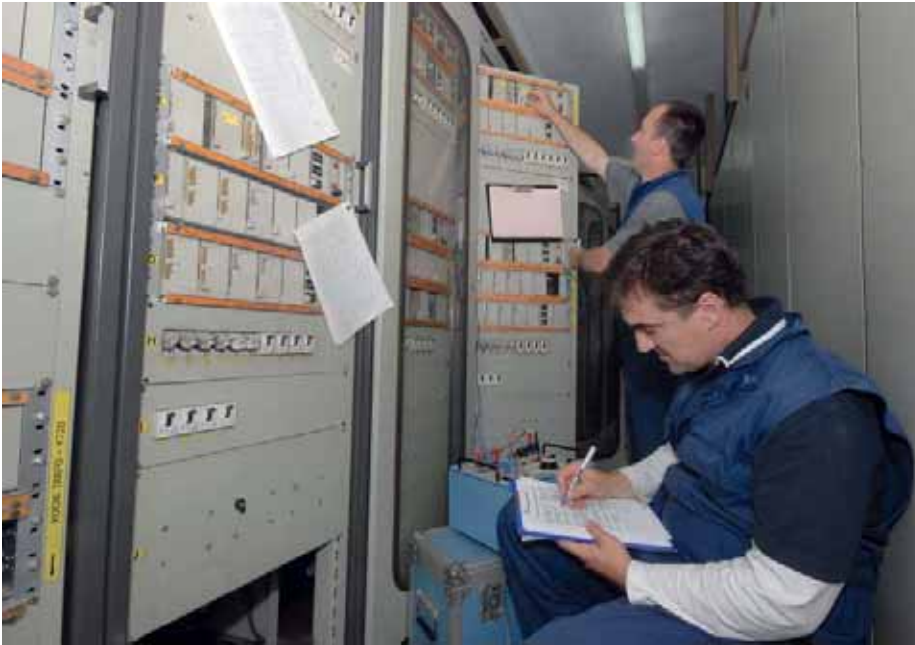
Ремонти у ТС 35/10 kV у року: ТС Зрењанин
