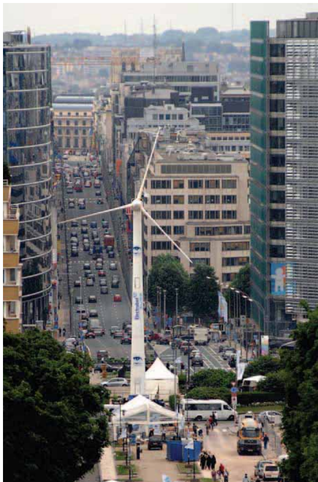
Ветрогенератори у метрополама у естетском нескладу
