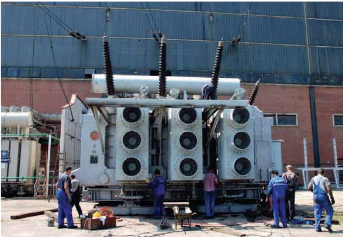
Замена трансформатора у ТЕНТ А
