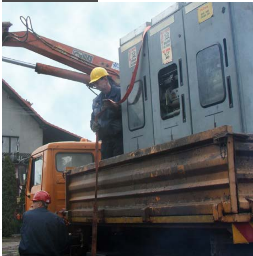
■ Возач Пековић и монтер Фабри учвршћују утоварени, неисправни, разводни орман из ТС
