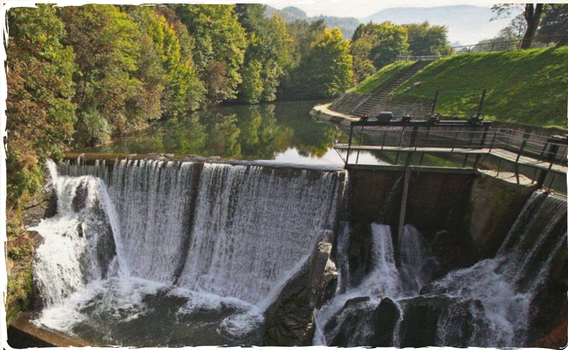
Хидроелектрана „Моравица“ у Ивањици (1911) Брана и деџаљи постројења електране
