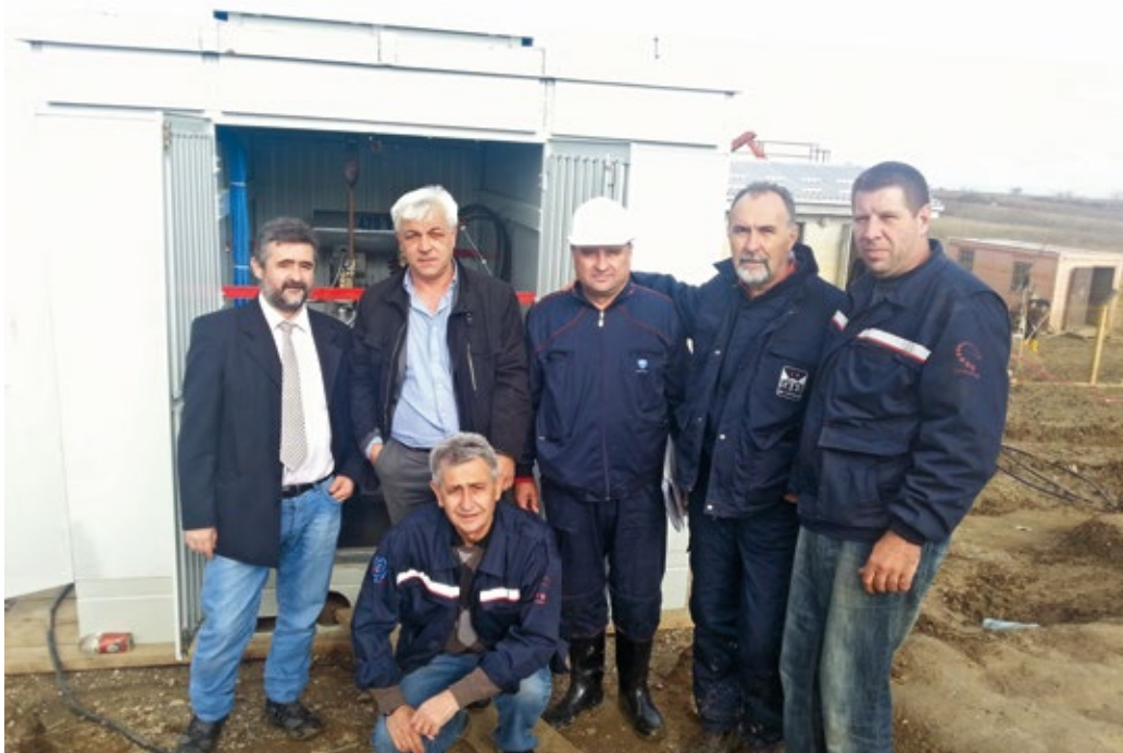
Радом мобилне трафостанице ЕДБ-а вода је испумпавана неупоредиво брже
