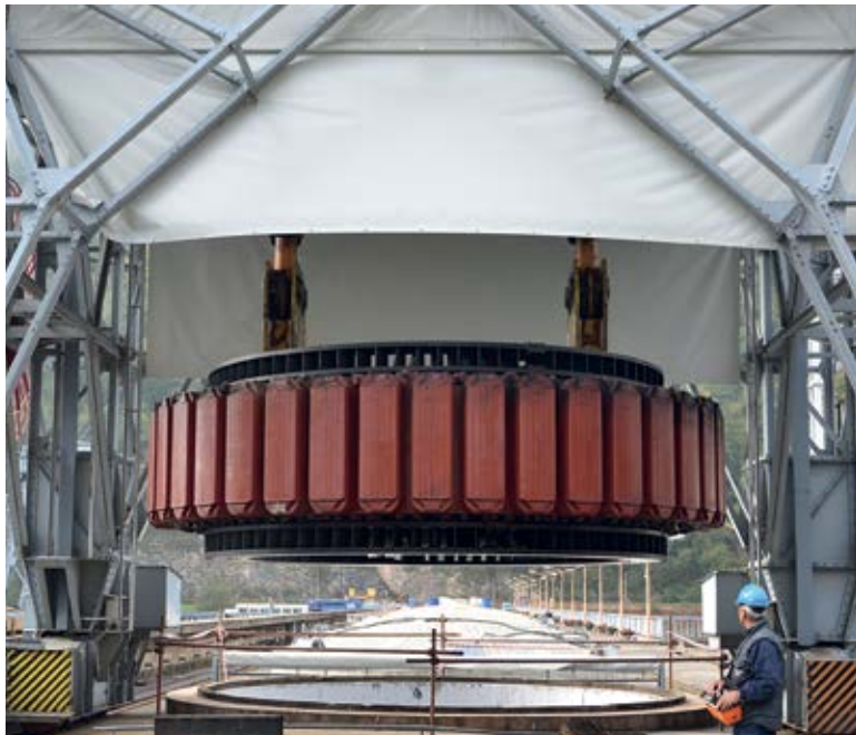
|| ХЕ „Зворник“ – демонтажа ротора
