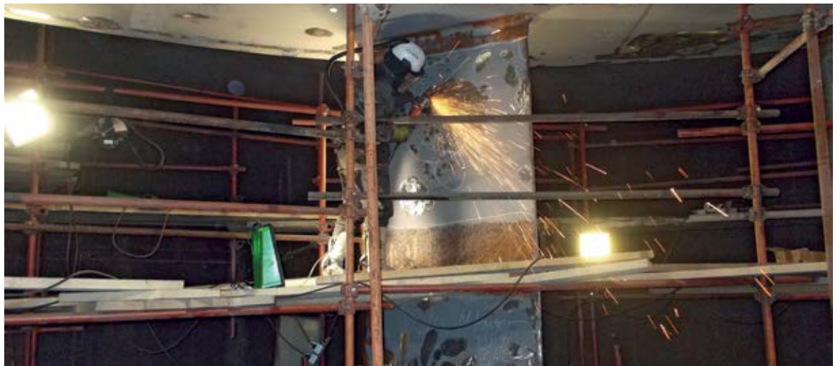
■ Санација статора турбине у проточном тракту
