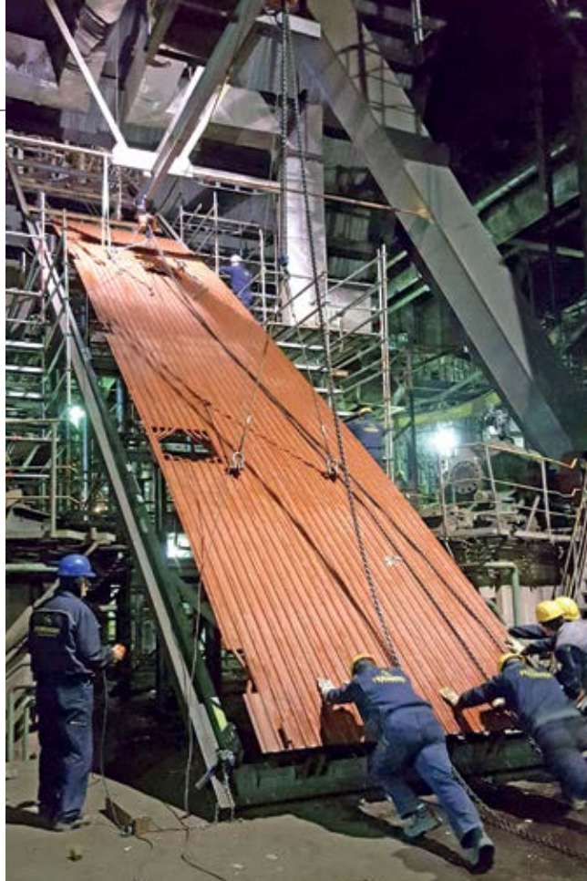
■ Подизање нових панела испаривача
