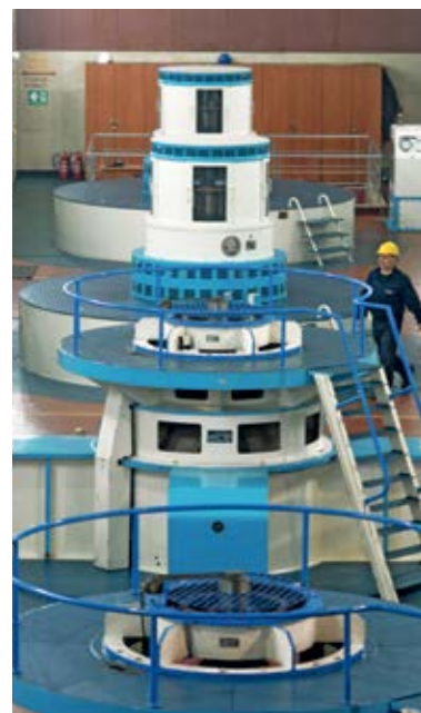
■ ХЕ „Врла 1“, у току је капитални ремонт А1
