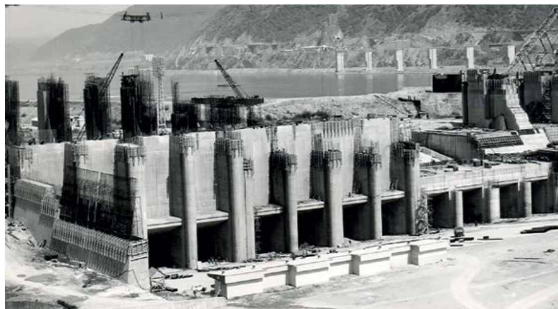
■ Електрана у време изградње
