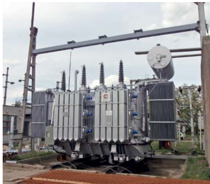
■ Прва фаза реконструкције ТС 110/35 kV „Алибунар“
