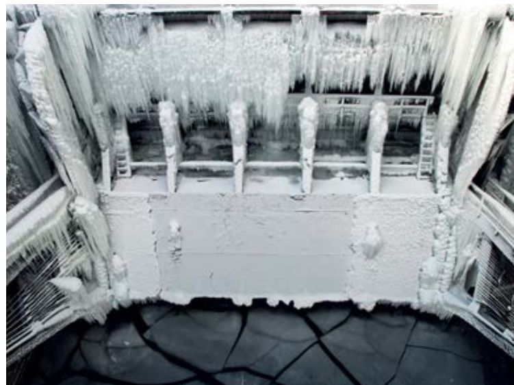
■ ХЕ „Ћердап 2“, затварач преливне бране окован ледом
