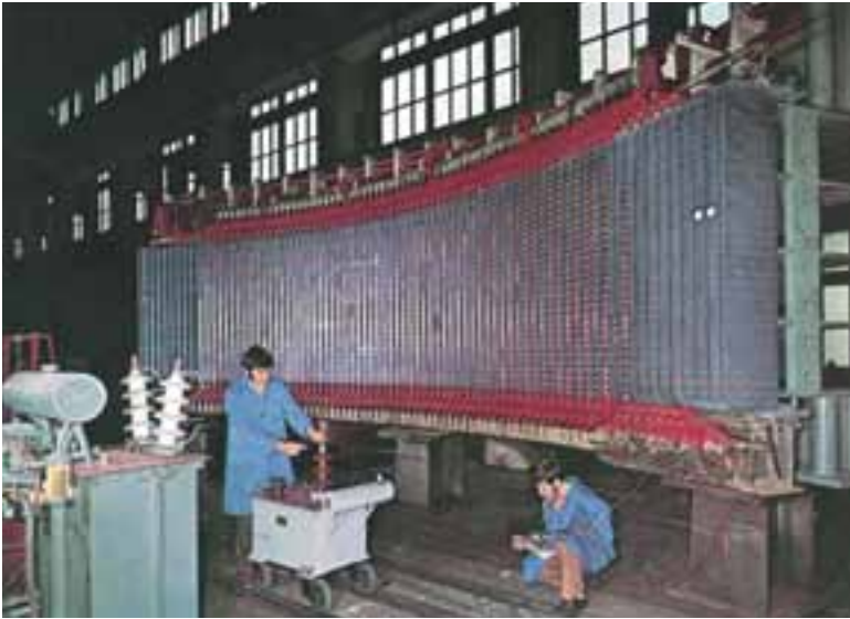
Монтиража синхронизатора генератора
