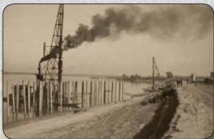
Почетак градње водоујврга за приспанишће на главном току Дунава
