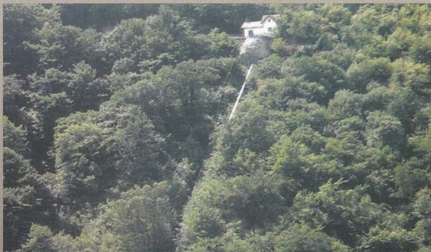
ХЕ "Вучје"- завршетак канала, водна комора и почетак доводне цеви
