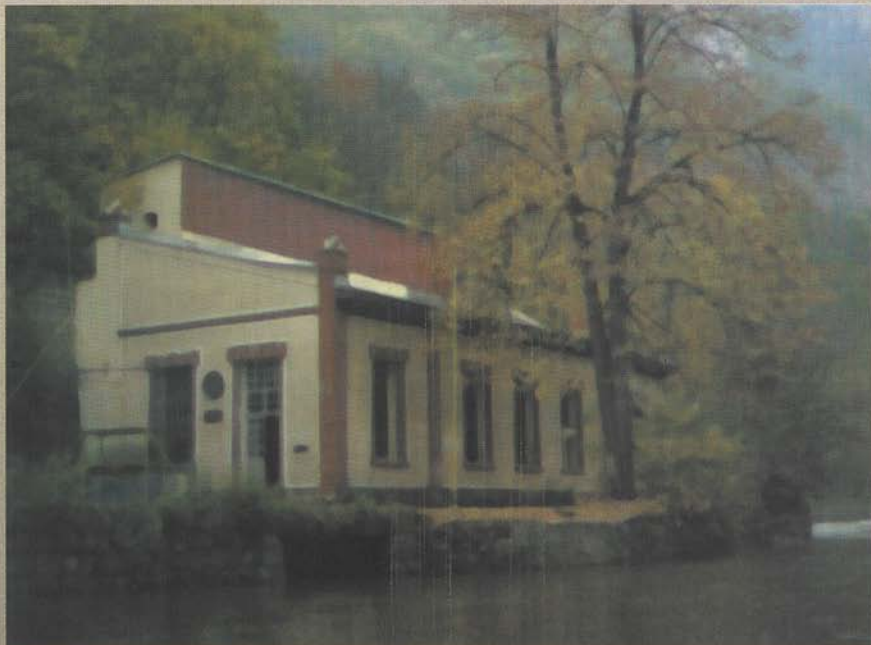
Хидроелектрана на Бетињи, изграђена 1900. године. Ради на Теслиним принципима полифазних струја
