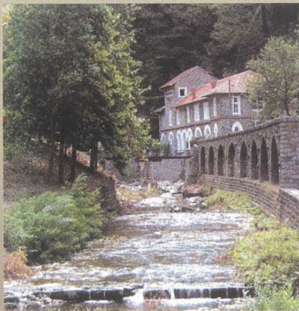
Хидроелектрана "Вучје" пуштена је у рад 1903. године
