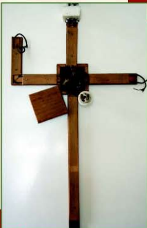
На почетку се кућна инсталација изводила помоћу дрвених летвица
