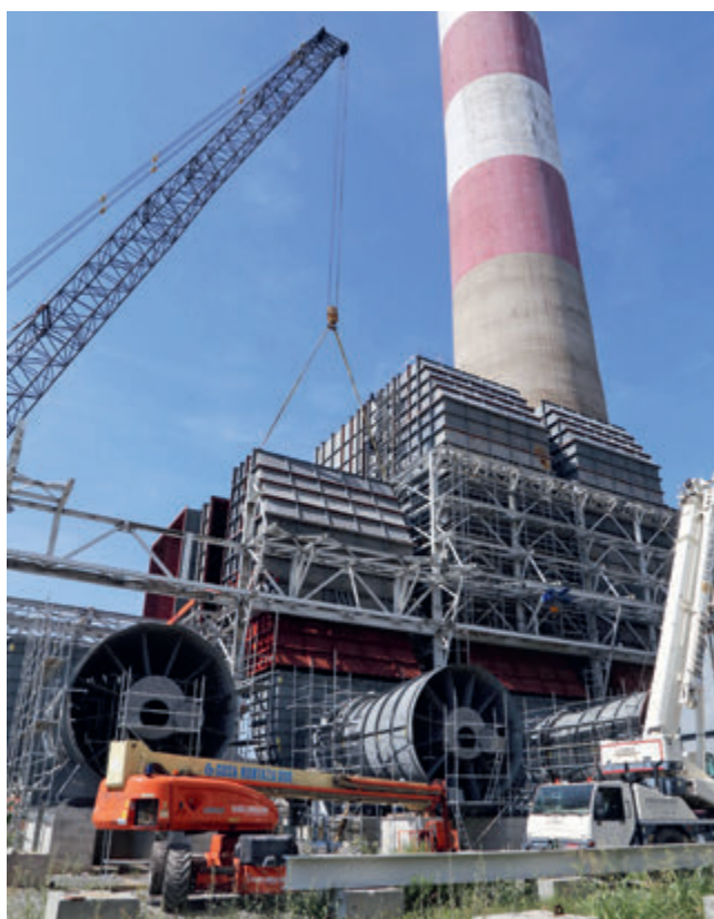
■ Монтажа канала димног гаса
