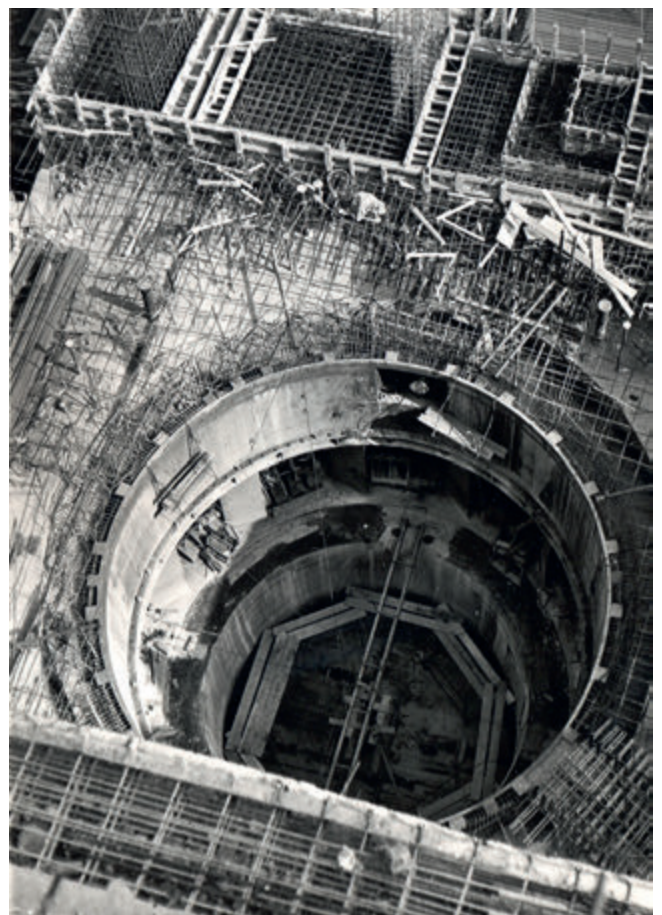
■ Турбинска јама једног од агрегата 1969. године
