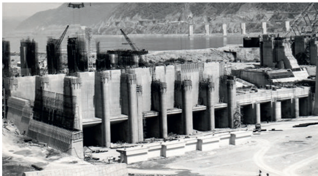
У изградњу ђердапске електране утрошено је 3,2 милиона кубика бетона, 167.000 тона арматуре...
