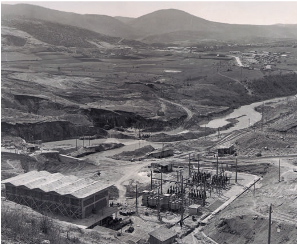
■ Разводно постројење и машинска зграда ХЕ „Кокин Брод“ у изградњи
