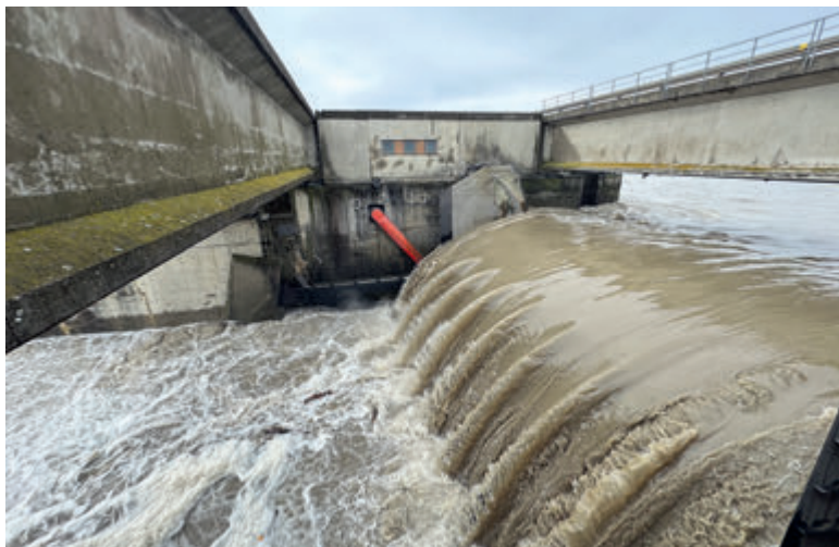
■ Преливно поље на ХЕ „Грајфенштин“, снаге 293 MW, на Дунаву у Аустрији
