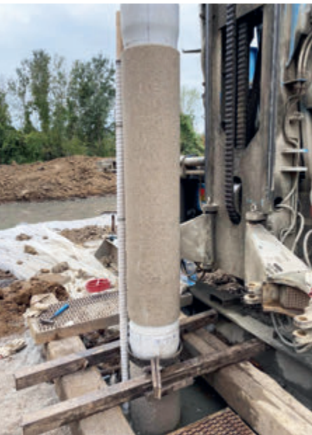
■ Изградња бунара за дубинско одводњавање
