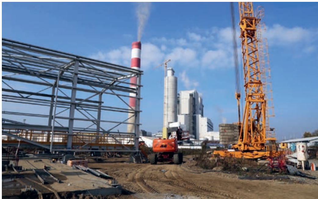
■ Метална конструкција вагонског истовара кречњака
