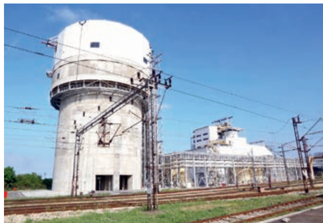
■ Силос ОДГ постројења у ТЕНТ А
