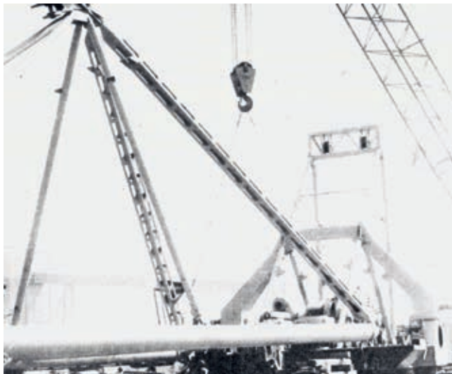
■ Монтажа првог багера на копу „Тамнава-Западно поље“
