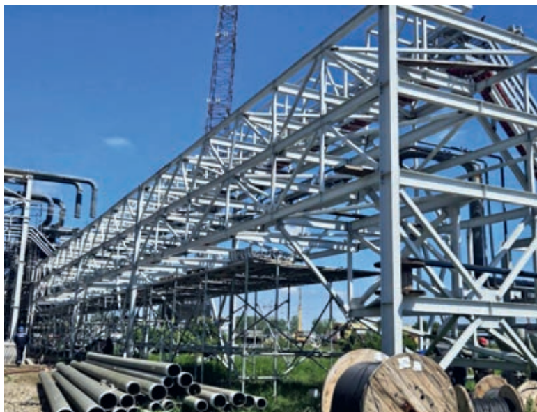
■ Цево кабловски мостови
