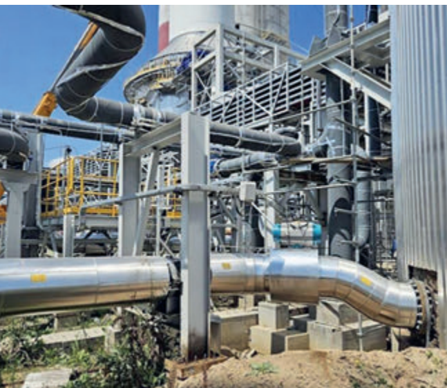
■ Систем дистрибуције технолошке воде
