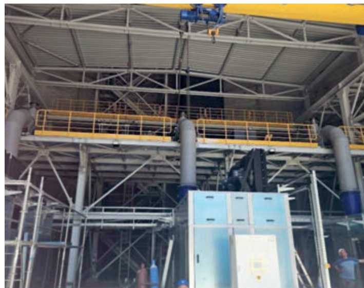
■ Компресорска станица оксидационог ваздуха
