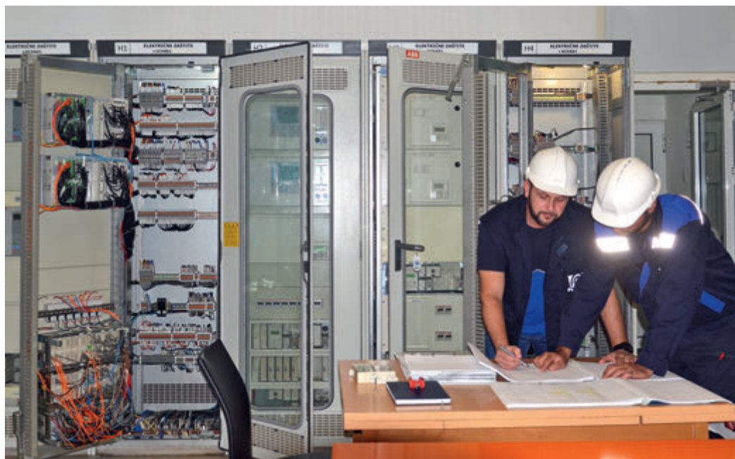
■ Капитална реконструкција система електричних заштита агрегата Х3 и Х4 у ХЕ „Бајина Башта“
