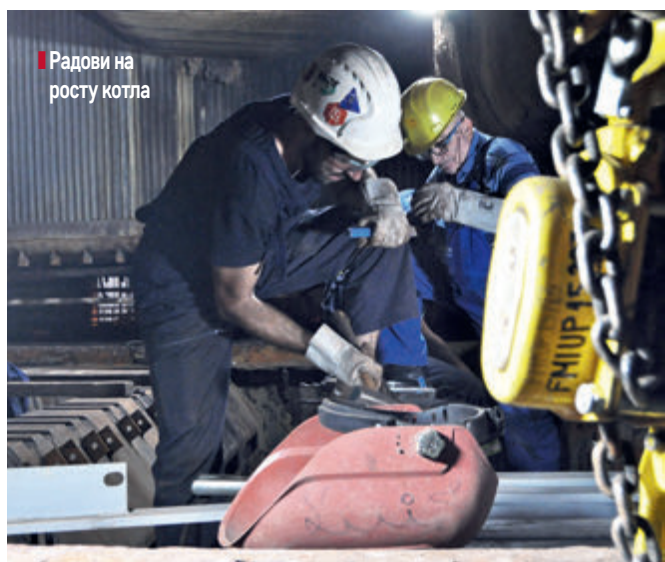
■ Демонтажа излазне коморе прегрејача 5
