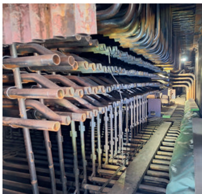
■ Демонтажа У рачви на коти 71 метар
