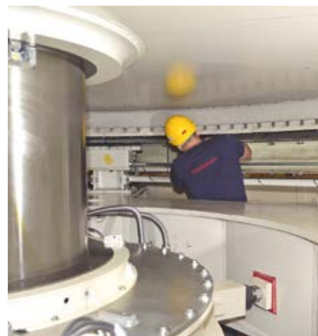
■ Радови на замени механичке кочнице агрегата
