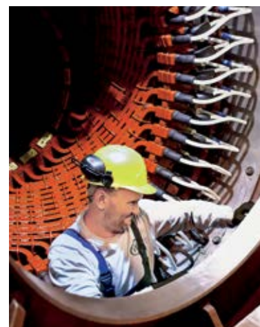
■ Радови на статору генератора
