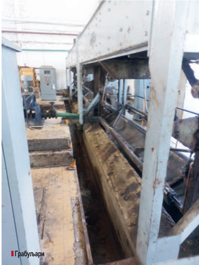
■ Монтажа дифузора расхладне пумпе
