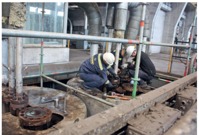
■ Ремонт блока 5 ТЕ „Колубара“
