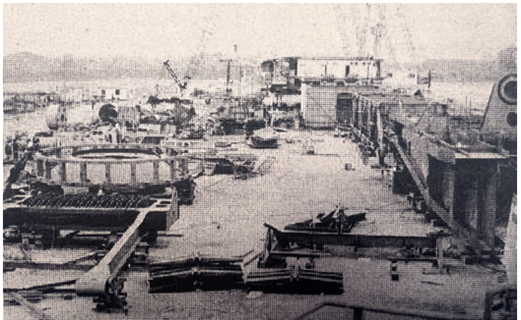
■ Монтажни плац у Каленићу
