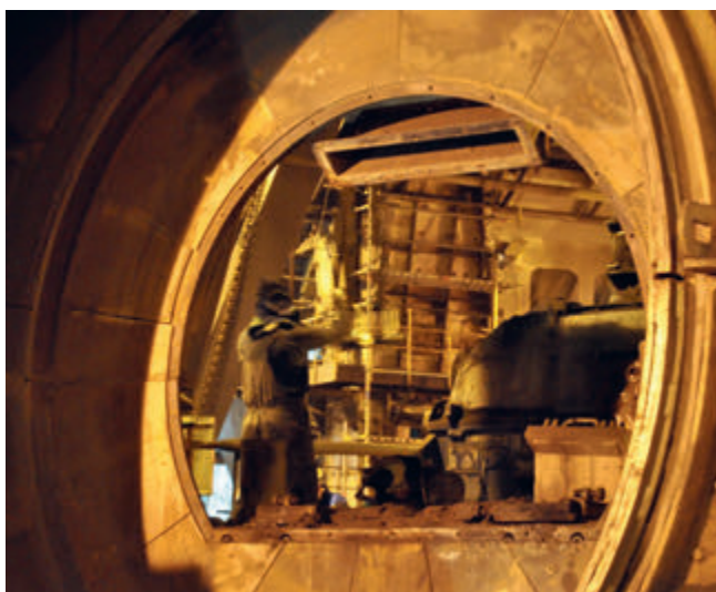
■ Ремонт у ТЕНТ А
