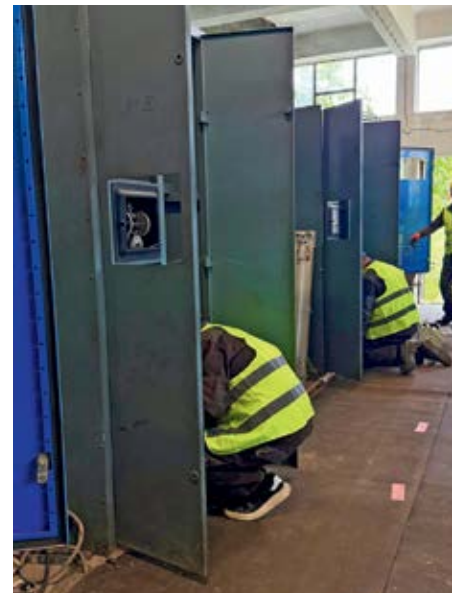
■ Демонтажа електроормара
