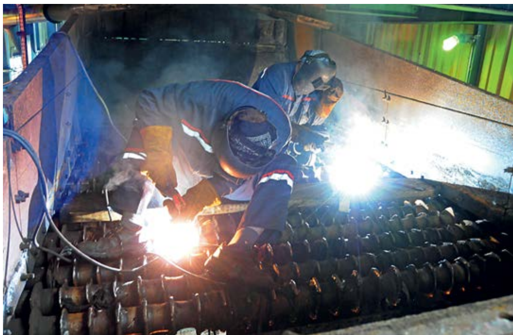
■ Наваривање ролен рост решета
