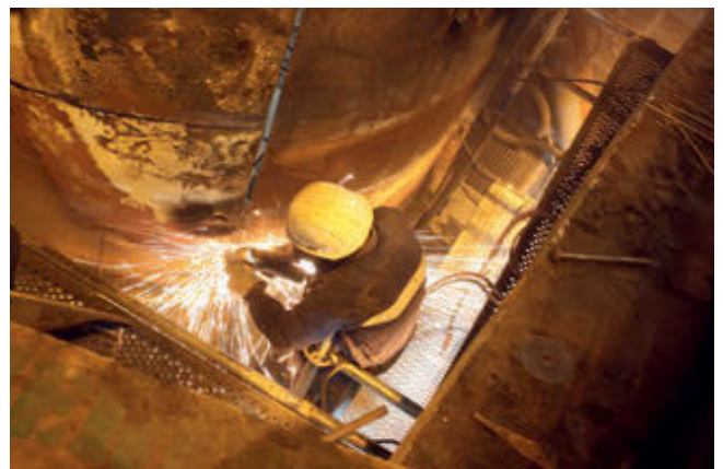
■ Ремонтни радови на котлу
