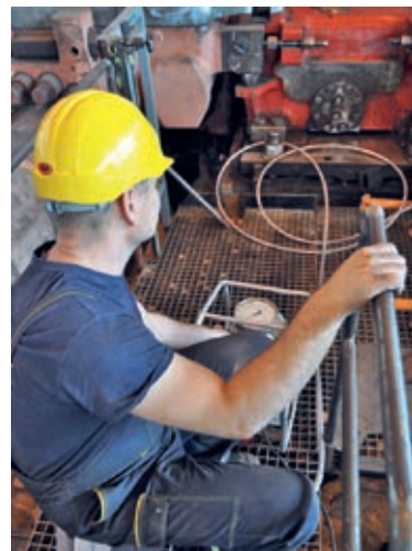
■ Провера завртњева на оклопу турбине
