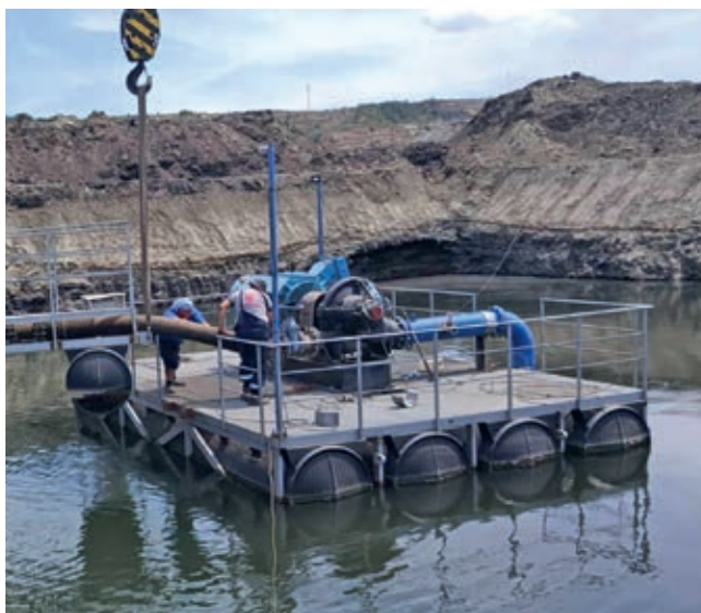
■ Изградња новог водосабирника
