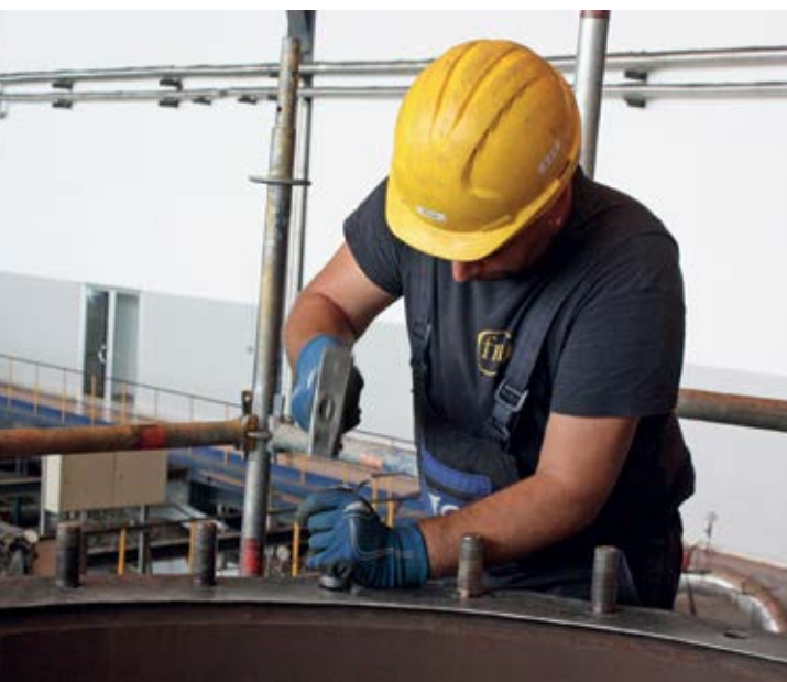
■ Припрема за постављање заптивки
