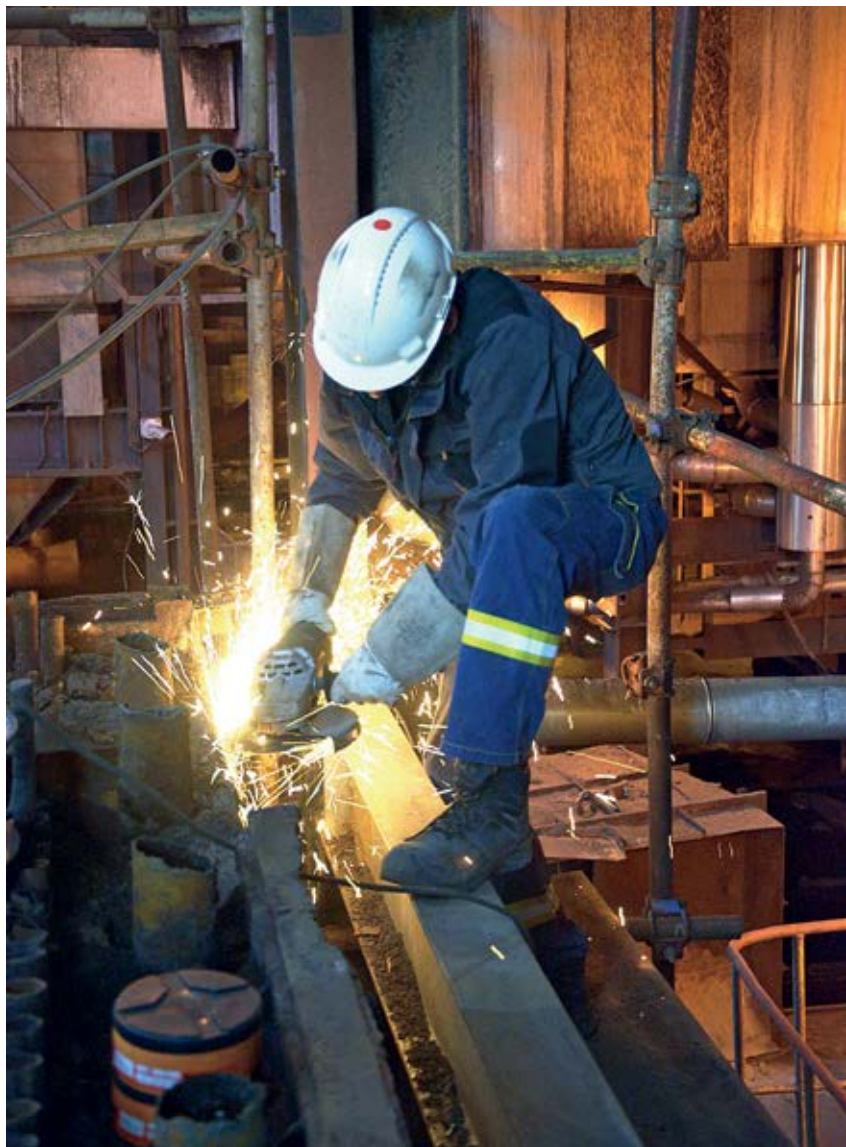
■ Ремонтни радови у Топлани
