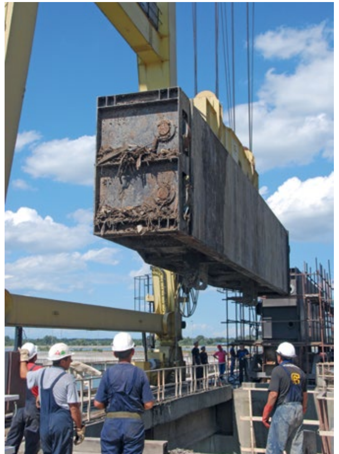
■ Извлачење сегмента брзог предтурбинског затварача после 10 година проведених у води
