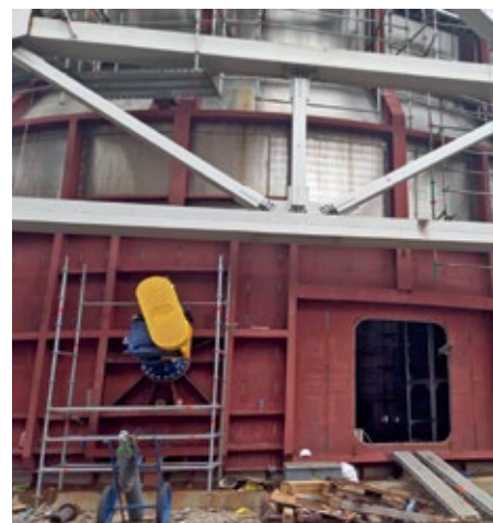
■ Монтажа и ламинирање рециркулационих пумпи
