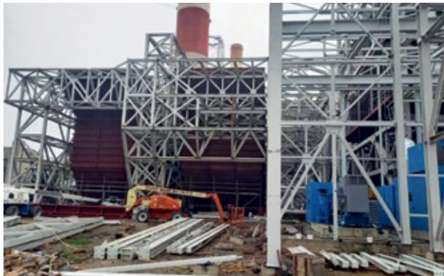
■ Канали димног гаса блокова 5 и 6 – монтажа
