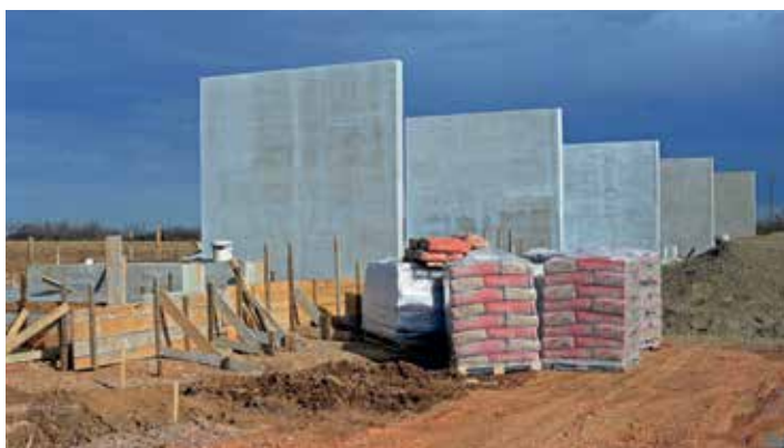
■ Почетак изградње трафостанице
