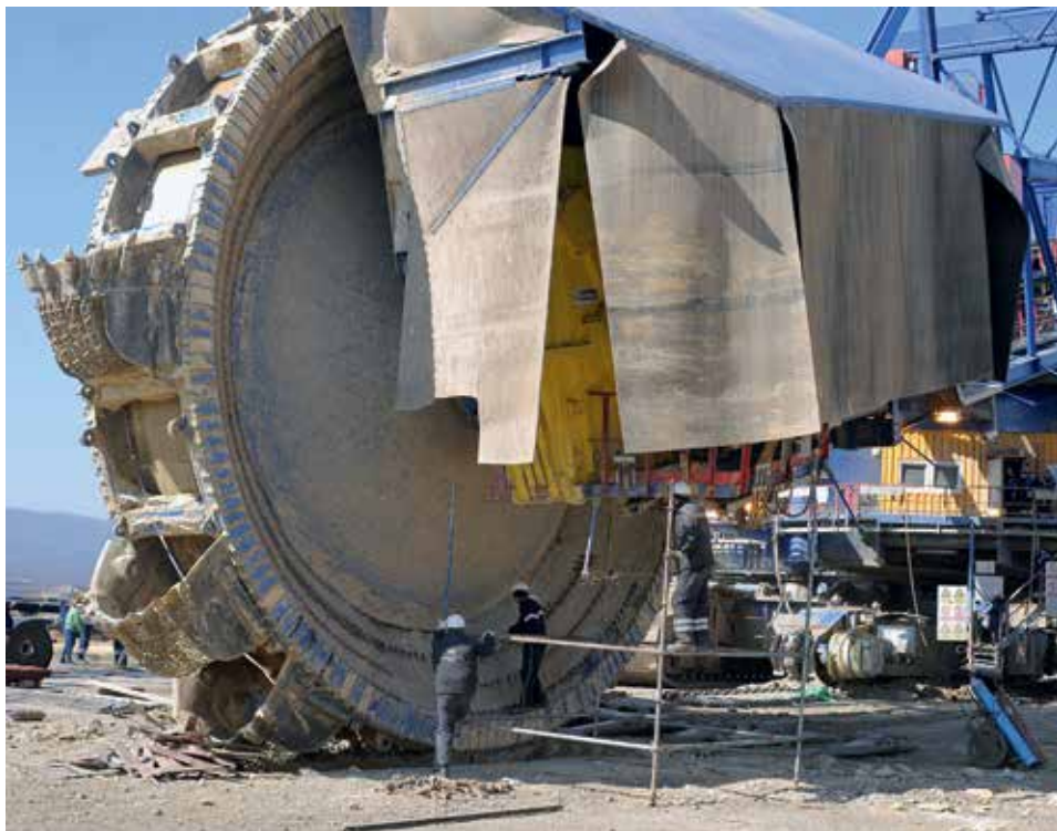
■ Детаљ са ремонта роторног багера
